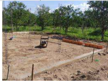
Relleno y compactación del terreno
