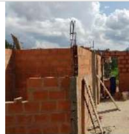
Levantamiento de muros
