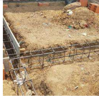
Armado de refuerzo
